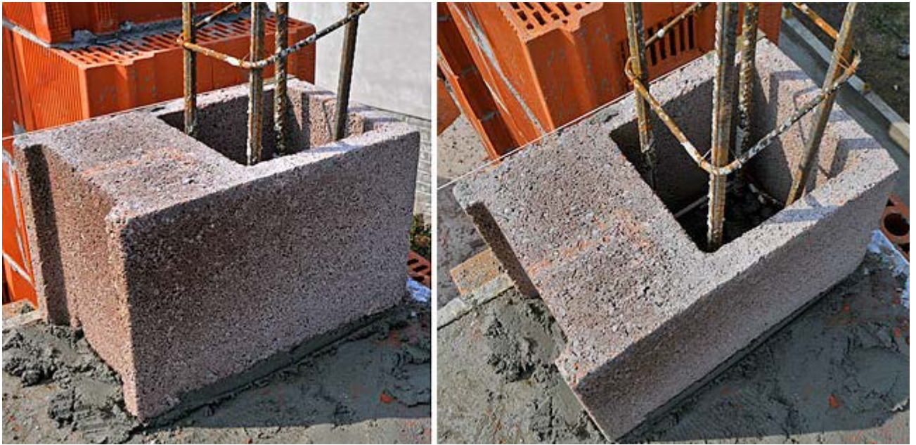
Пример вертикального усиления внутренних углов.
