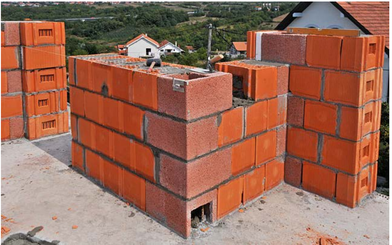
Пример вертикального усиления внутренних углов.
